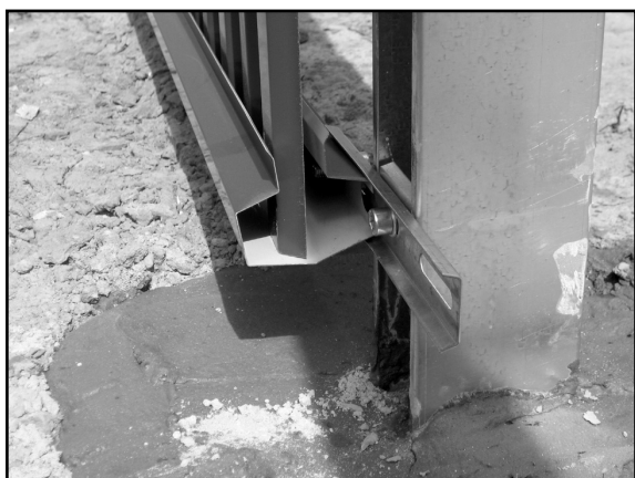
Фото 12. Деформация нижнего продольного профиля под весом профнастила при отсутствии технологических подкладок
