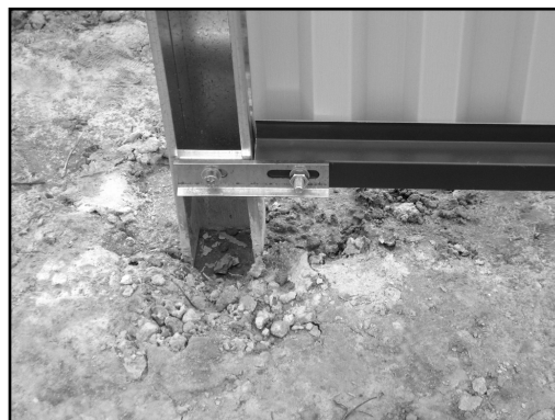
Фото 21. Нижний продольный профиль с укороченной планкой в сборе
