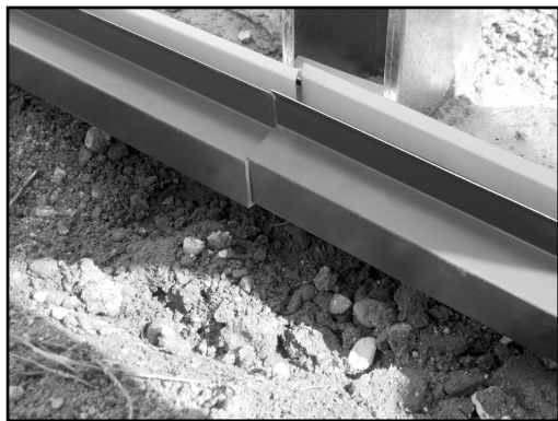
Фото 7. Стык профилей до выравнивания
