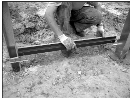
Фото 17. Установка укороченного нижнего продольного профиля
