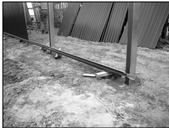
Фото 13. Установка листов профнастила в паз нижнего продольного профиля
