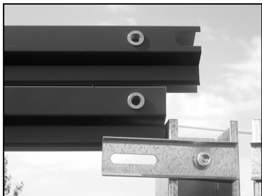
Фото 15. Схема укорачивания верхнего и нижнего профилей
