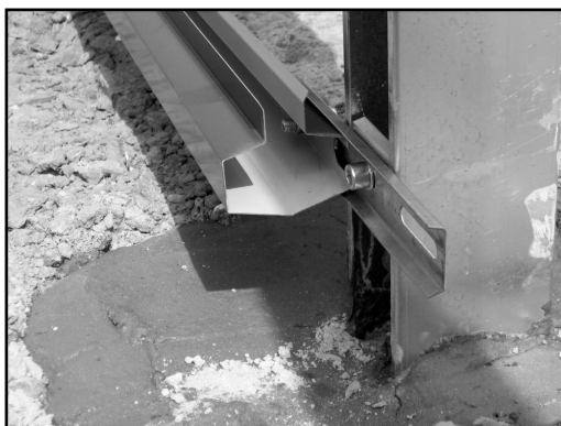
Фото 5. Крепление нижнего продольного профиля к планке
