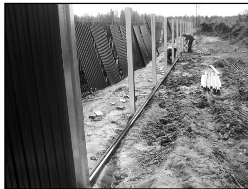
Фото 6. Крепление нижних продольных профилей на участке забора
