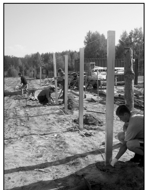
Фото 2. Установка промежуточных стоек
