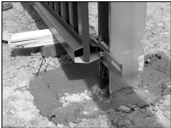
Фото 10. Установка технологических подкладок
