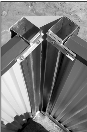
Фото 26. Наружный угол, вид изнутри
