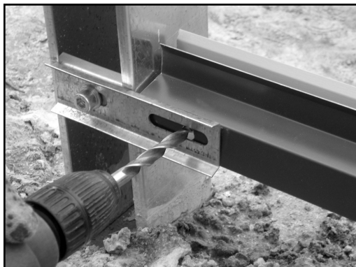
Фото 16. Сверловка отверстия в укороченном нижнем продольном профиле
