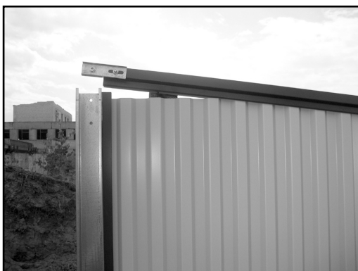
Фото 22. Крепление укороченной планки сначала к верхнему продольному профилю и установка верхнего продольного профиля с укороченной планкой на профнастил
