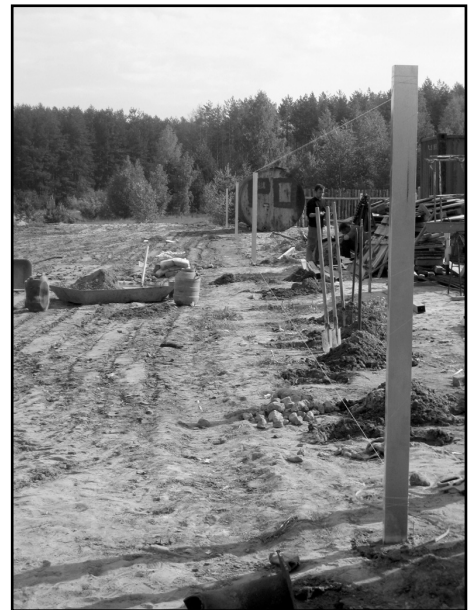
Фото 1. Установка основных стоек (С 1 , С 2 , С 3 .....)
