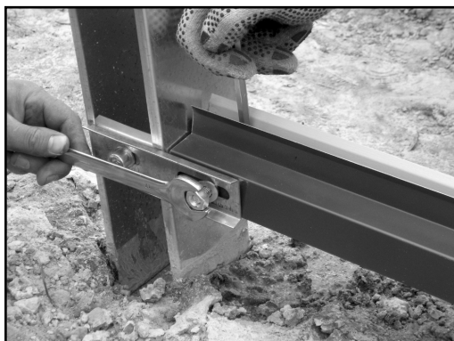
Фото 20. Затяжка гайки M10x25
