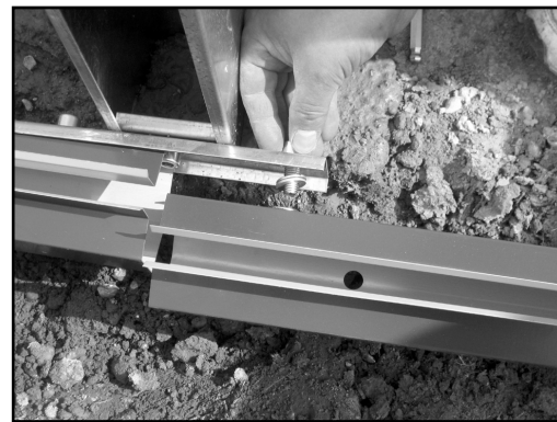
Фото 8. Подкладка шайб для выравнивания стыка профилей
