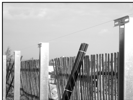
Фото 3. Установка верхних планок
