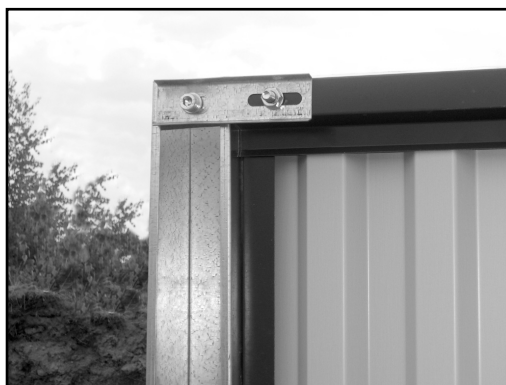
Фото 23. Верхний продольный профиль с укороченной планкой в сборе
