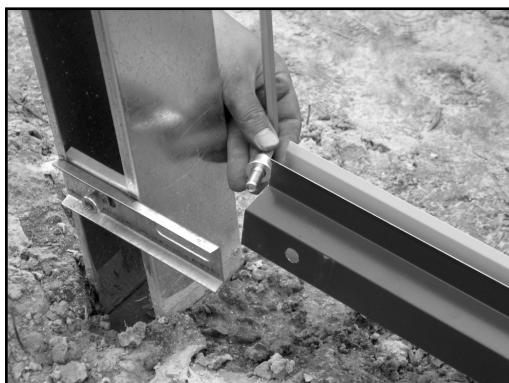
Фото 18. Установка винта M10x25 с внутренним шестигранником на шестигранный ключ
