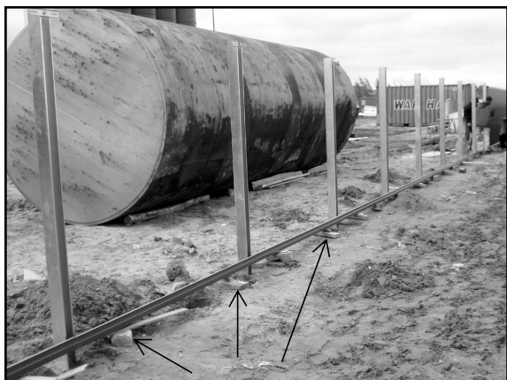
Фото 11. Установка технологических подкладок на участке забора
