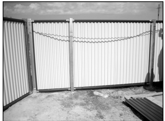
Фото 28. Наружный угол 120°, вид изнутри
