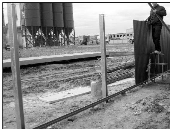
Фото 14. Установка листов профнастила и верхнего продольного профиля
