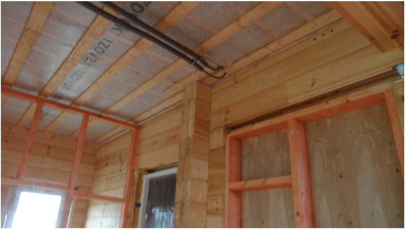
Вид на перекрытие в зоне прихожей, правее за стенкой – котельная, над головой – санузел 2 этажа
