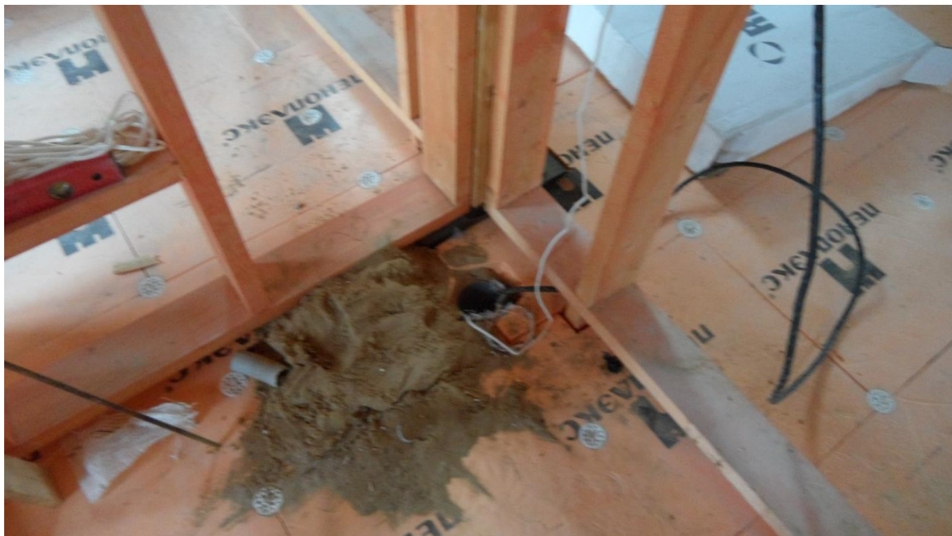
Ввод кабеля в дом (санузел 1 этажа)
