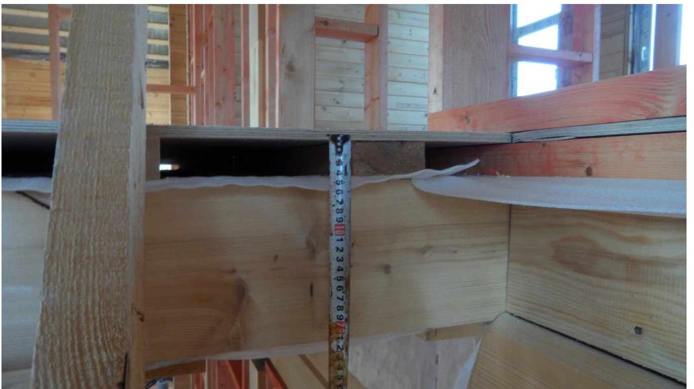
Перекрытие между 1 и 2 этажами в зоне лестничного пролета
