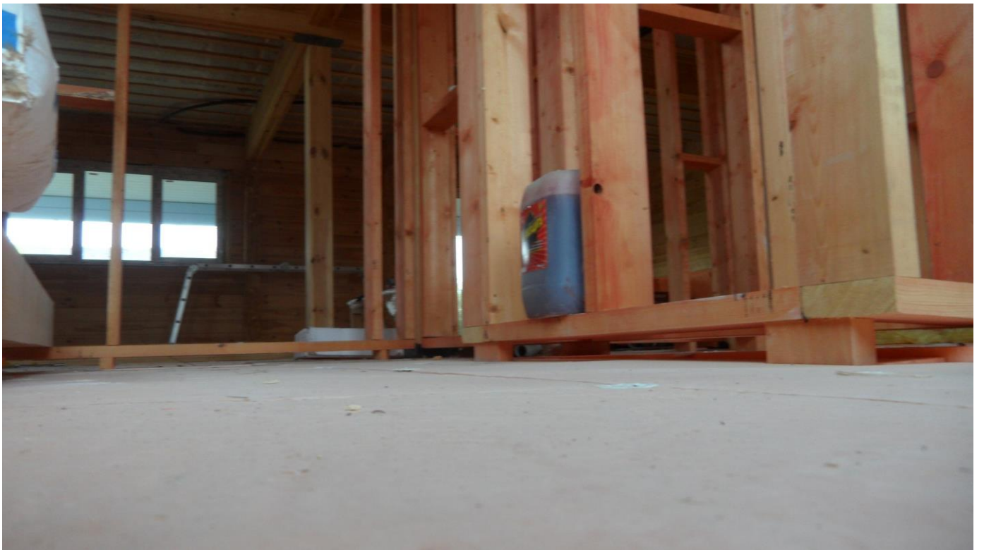
Вид с уровня чернового пола спальни 1 этажа в сторону кухни
