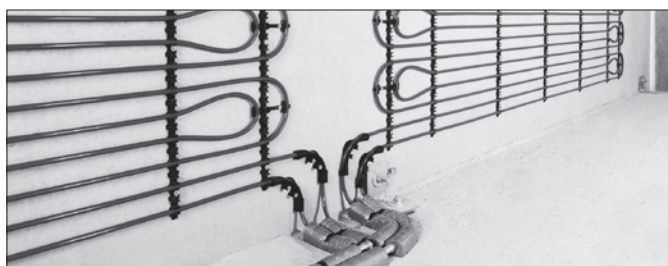
Система напольного отопления/охлаждения («мокрый» способ укладки труб)
