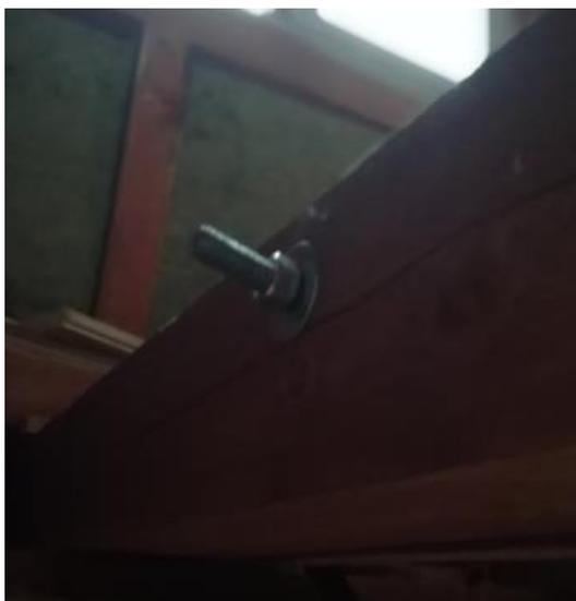
Закрепление по 4 болта в каждый угол сочленения под крышного пространства и пола второго этажа
