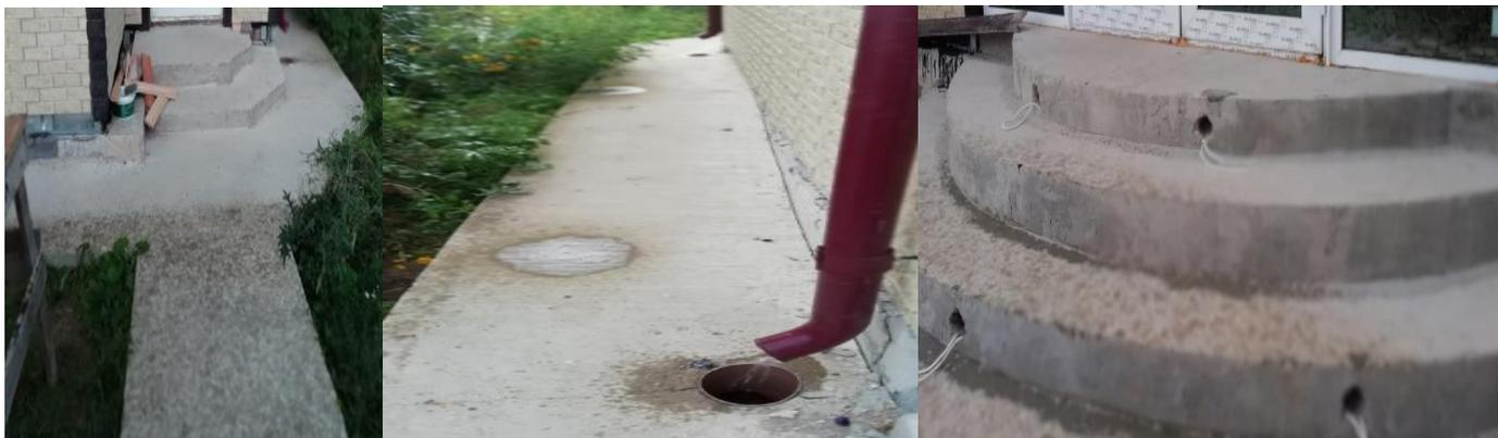
2) Устройство основания под пластиковый цоколь (без монтажа цоколя) с монтажом отливов.
