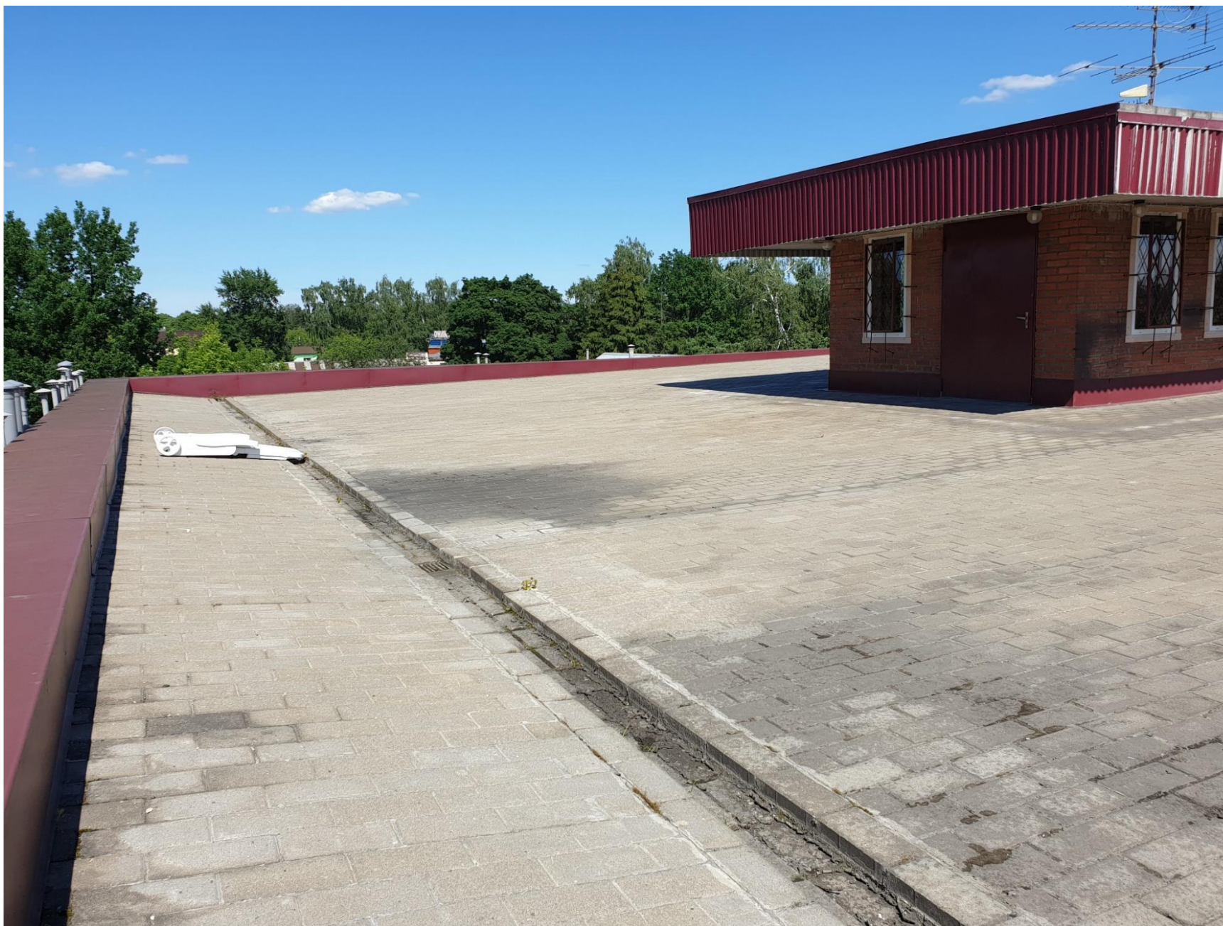
Рис. 3-4. Продольный водосточный жёлоб с 3-мя воронками, прикрытыми решётками.
