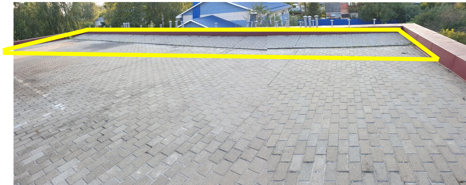
Рис. 5. Ориентировочные границы участка ремонта кровли (изображение искажено).
