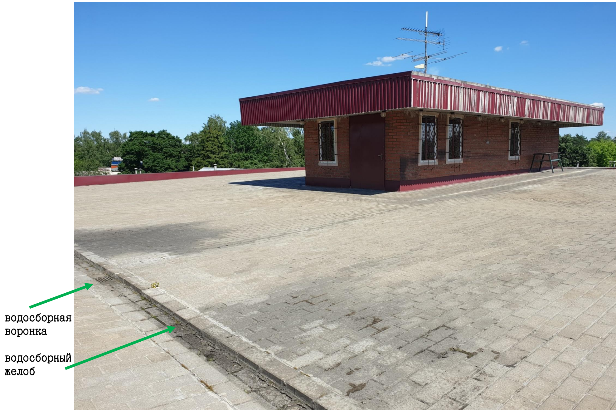
Рис. 1. Выход на кровлю и вид плоской кровли жилого дома.
